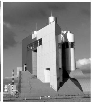
山の下みなとタワー
