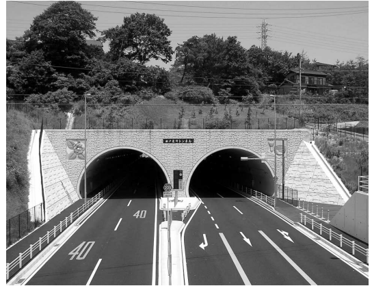
瀬戸菱野トンネル
