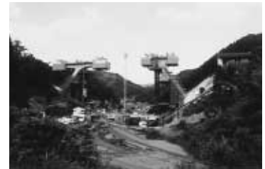
小原橋（施工中）
