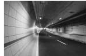
飛鳥山公園下をNATM工法 で建設した飛鳥山トンネル
