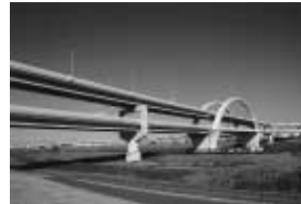
五色桜大橋 (荒川渡河部)
