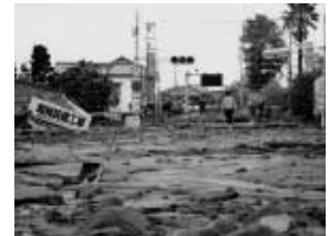
土石流被災状況（H5.5.2撮影）
