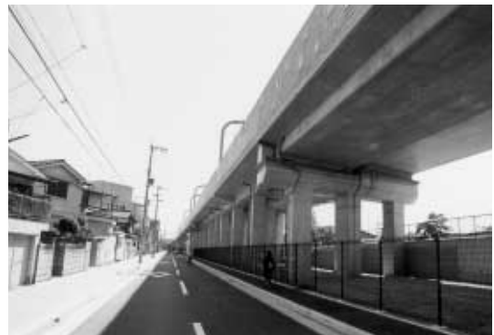
高架区間一般部
