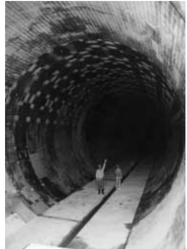
雨水北幹線第1号管渠の内部
