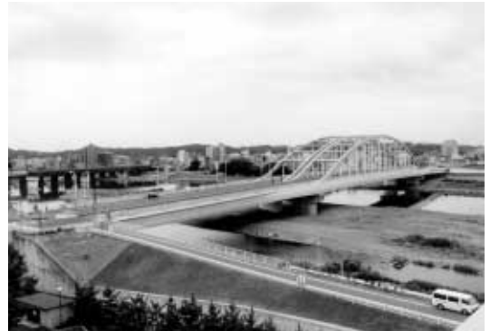
多摩水道橋整備完了後（平成13年6月）
