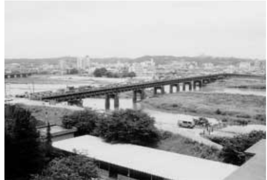
多摩水道橋整備着手前（昭和63年6月）
