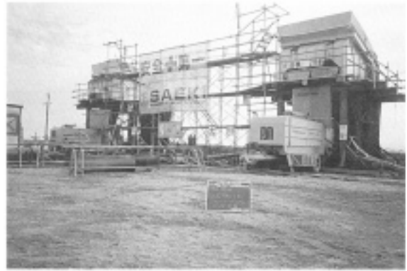
2台の圧送機設置状況
