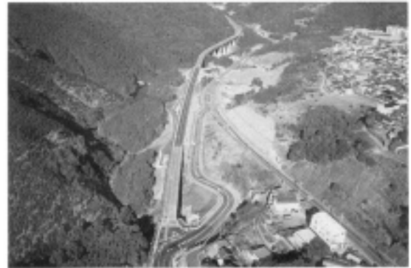
全景(起点側より望む)
