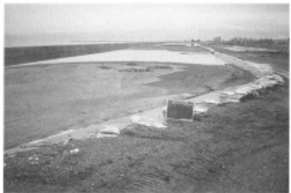
固化処理土土捨て完了状況
