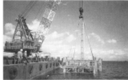
基礎捨石マウンド均し機例（八脚歩行式）
