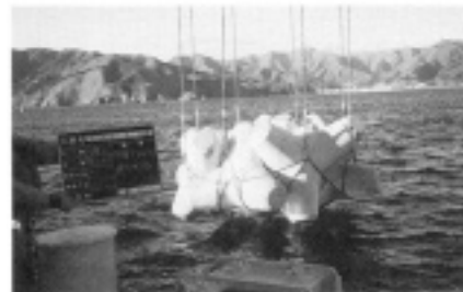
被覆ブロック籠方式据付
