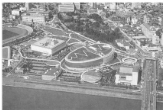
信濃川上空から見た建物と周辺の全景 建物のまわりに「空中庭園」と「ブリッジ」が配置されている。
