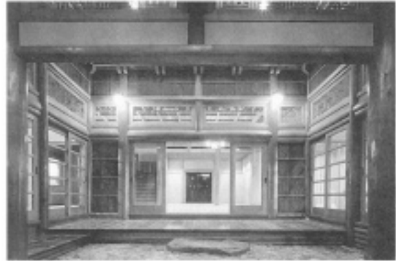
本館玄関部分
