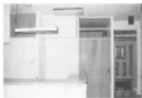
建物内に風の通り道としてランマを設置
