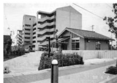
西側道路から集会所を見る
