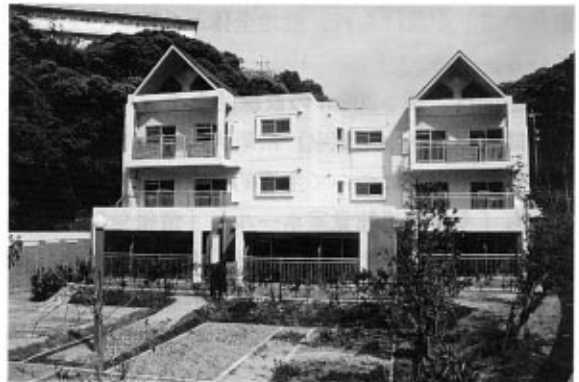
内浦団地住棟外観
