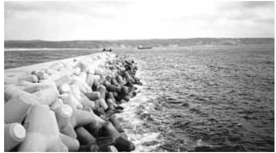
防波堤基部から先端部
