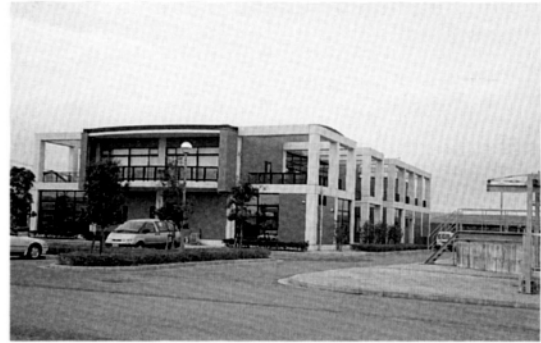
武蔵東部浄化センター（中核施設）
