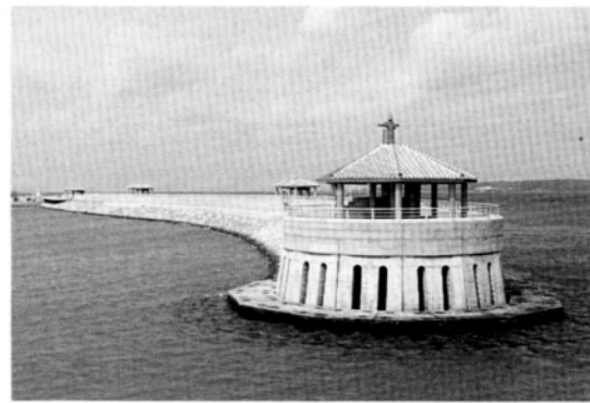
港内側先端より堤頭部を望む
