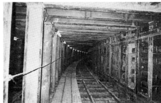
単体シールドトンネル内（コンクリート打設前）
