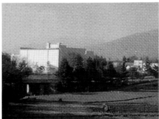
全景 (RDF 施設)
