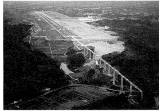
侵入灯橋梁 PALS側
