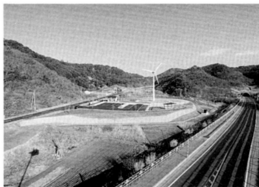
風力発電設備
