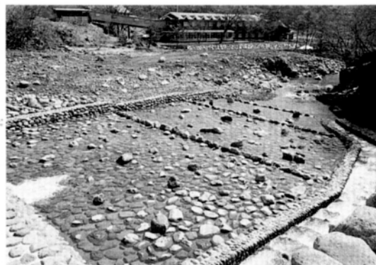
副ダム下流水路
