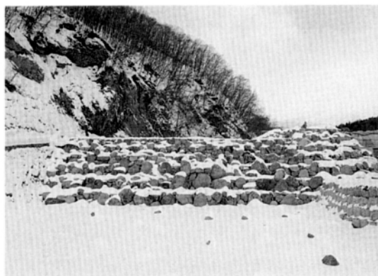
「CSG+石張」工法による葛根田川第1砂防ダム
