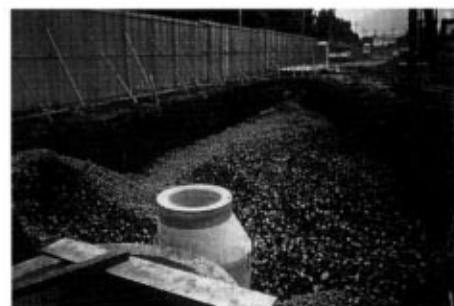
砕石空隙貯留施設
