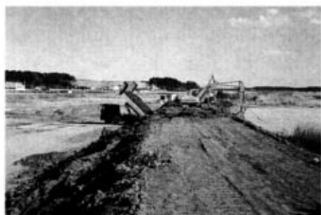
ストック土砂の再利用先(堤防嵩上げ)
