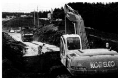
建設発生土の受入管理状況(湯崎ストックヤード)
