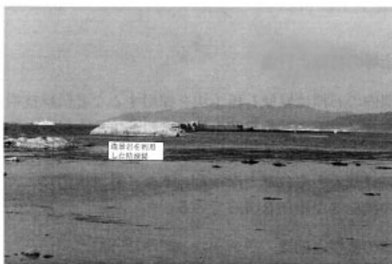
造景岩構造防波堤全景
