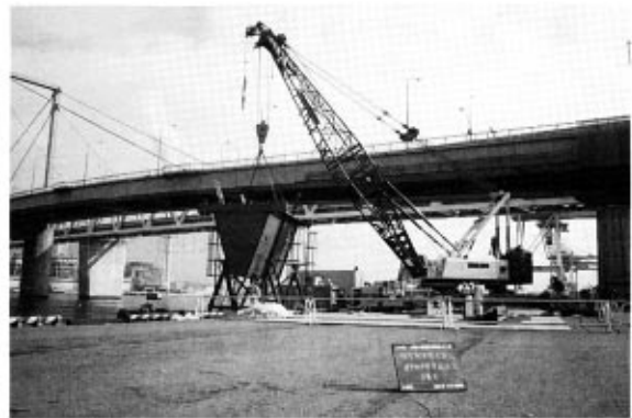
楔型矢板を運搬台船から吊り込む
