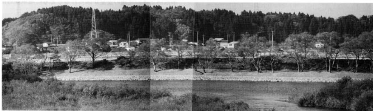
工事箇所全景
