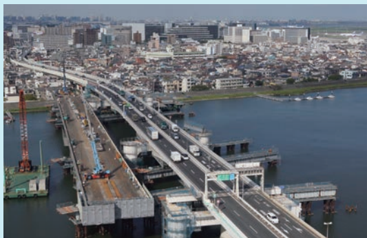
高速大師橋更新事業（2週間通行止めによる橋梁架け替え） (写真提供：首都高速道路株式会社)
