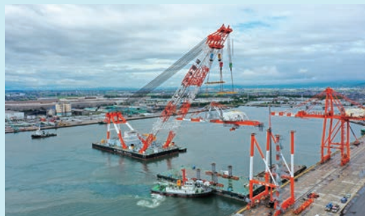
伏木富山港（新港地区）国際物流ターミナル ガントリークレーン1号機更新事業 (写真提供：富山県建設技術協会)
