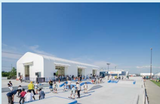
鳥屋野潟公園スケートパーク整備事業 (写真提供：新潟県建設技術協会)
