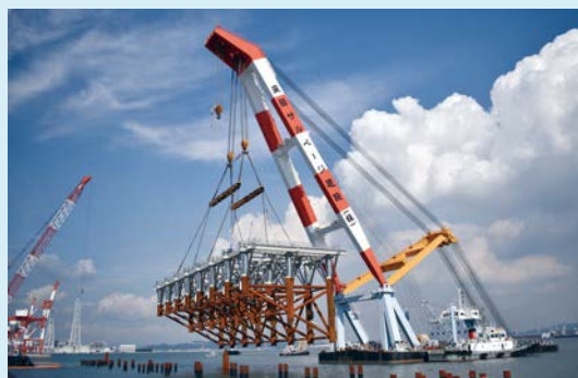
水島港国際物流ターミナル整備事業 (写真提供：中国地方整備局建設技術協会)
