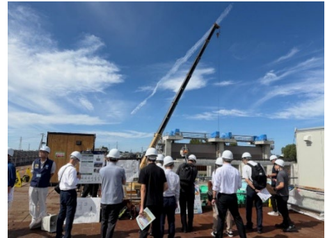
福島潟河川改修事業 現場研修の様子
