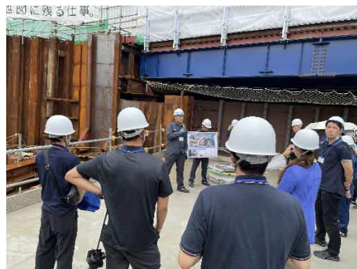
八潮市道路陥没事故復旧工事の視察の様子
