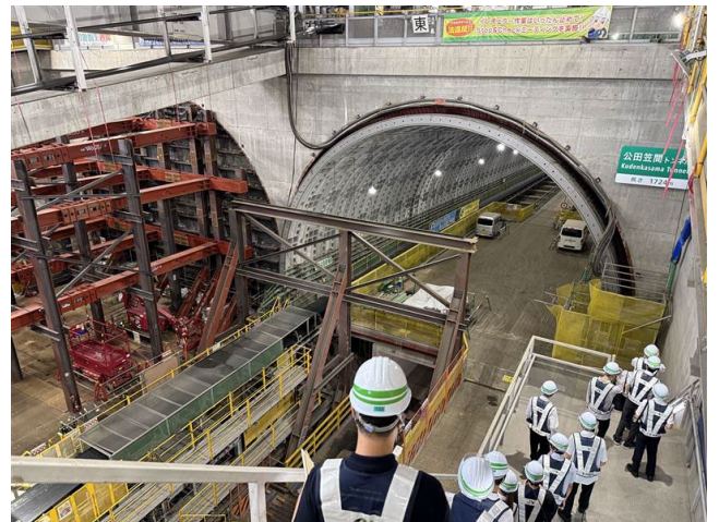
【公田笠間トンネルでの視察の様子】
