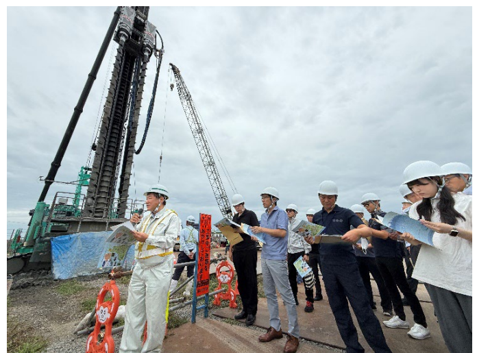
現場研修の様子「津軽自動車道 柏浮田道路整備事業」
