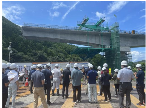
水俣川上部工の建設現場視察の様子
