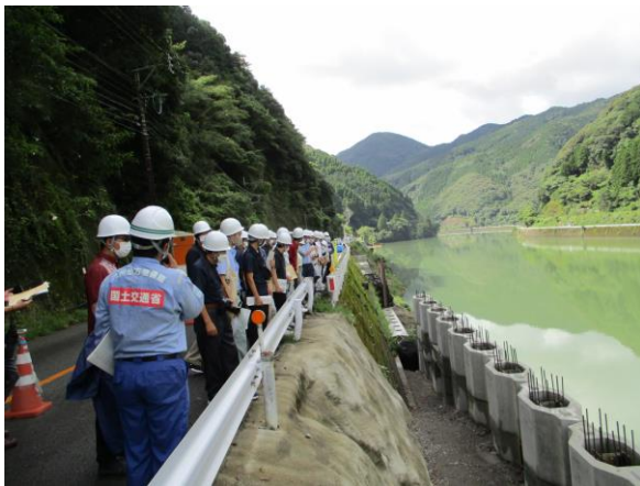
球磨川の擁壁設置現場視察の様子
