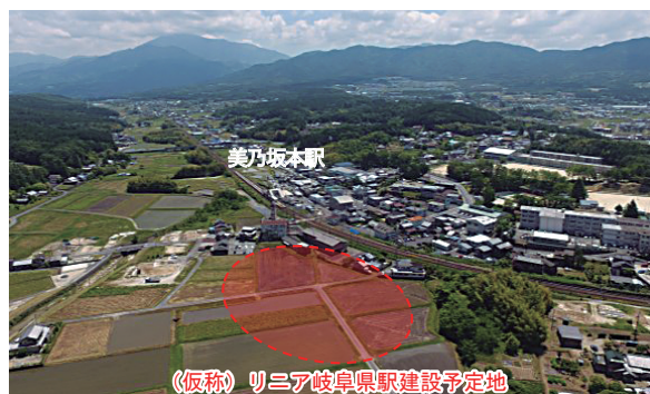
(仮称)リニア岐阜県駅建設予定地
