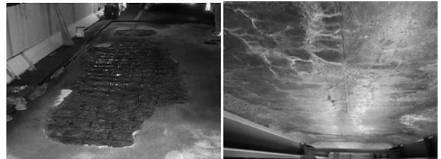
RC床版の損傷状況（左：上面、右：下面）
