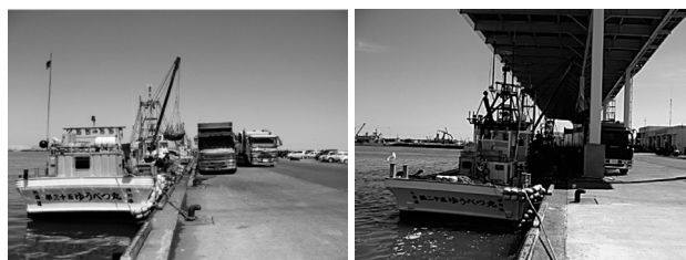
整備前 整備後 (天蓋施設により品質保持、異物混入のリスクが低下)
