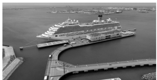
那覇港への大型クルーズ船着岸状況
