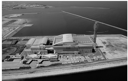
写真-1 岸和田市貝塚市クリーンセンター全景
