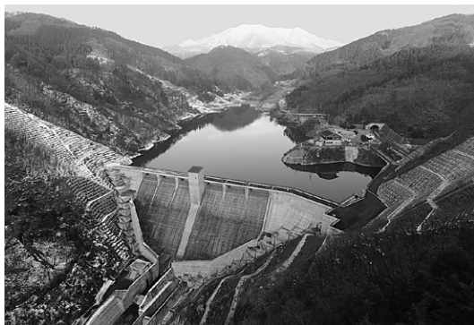
写真-1 試験湛水状況写真 (平成29年1月3日サーチャージ水位到達)
