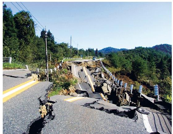
写真-2 一般国道351号長岡市宮路地先の道路崩壊（出典4）
