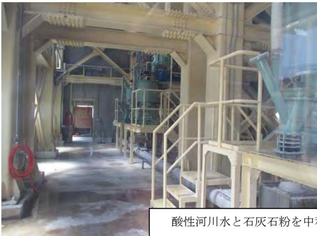
酸性河川水と石灰石粉を中和工場混合し湯川に投入
