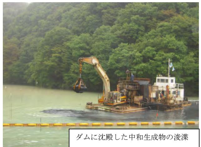
ダムに沈殿した中和生成物の浚渫
