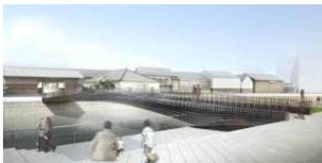
この6棟復元に続き、平成29年度に出島表門橋の架橋を目指しています。出島表門橋架橋プロジェクトは、江戸町側から、当時と同じように海を渡って出島に足を踏み入れることができる橋を架橋することで、海に浮かんでいた19世紀初頭の島を実感できるようにするものです。明治期中島川変流工事により、出島は扇形の内側が約18m削り取られ、川幅が当時と異なるため、往事の石橋の復元ではなく出島へのルートを復元するための架橋事業としています。勿論河川の管理、防災面の配慮が必要となり、また出島側は国指定史跡なので、史跡を壊して橋台を設置することができないため特殊な工法を採用しています。なお架橋は、旧出島橋の歴史的考証を行った上であえて、架橋する橋が“復元”と混同されないようなデザインとしています。
