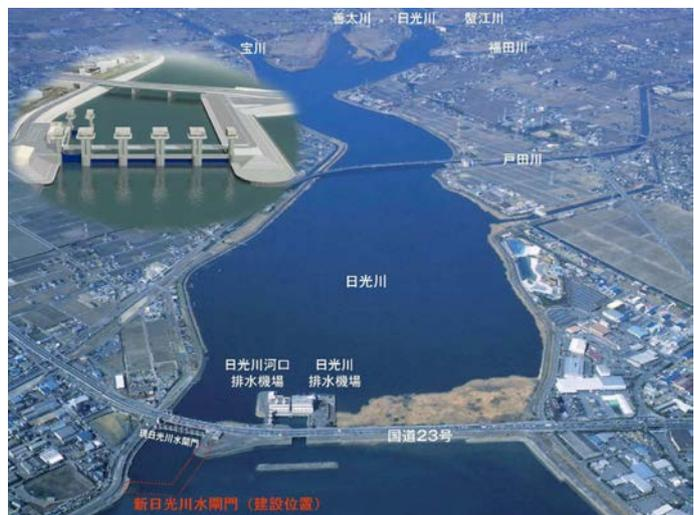
現水閘門は水門8門、閘門が1門ですが、経済性、流下能力等から水門4門、閘門1門で径間長20mとしました。水門敷高は日光川本川の改修計画で定められた流下能力を確保できるT.P-5.8mとしています。大規模地震及び不同沈下への対応として、躯体は、鋼板と鉄筋コンクリートを用いて造る鋼殻構造といった丈夫な構造を採用することとしました。
