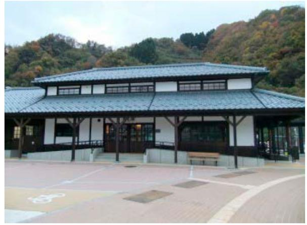
整備の中心となる勝山駅舎は、大正3年に京都電灯株式会社によって、京福電気鉄道の開通時に創建されて以降、勝山市の発展に大きく寄与し、平成16年2月に国登録有形文化財に指定されました。駅舎改修にあたっては、文化財の価値を損なうことなく極力創建時の板張りと漆喰の外観に復元しました。駅前ロータリー広場整備では、歩道部及び車道部に無散水融雪装置を設置しています。この融雪装置は、隣接する工場の温排水から熱交換機により熱エネルギーを活用し、不凍液により循環する仕組みとなっています。また、テキ6展示施設のテキ6とは、大正9年に製造された北陸初の電気機関車で、奥越地域と県都福井市を結び、多くの物資を輸送し地域の発展に貢献した車両で、駅前広場に動態可能な状態で保存展示しました。これらの整備は平成20年度から実施され、平成25年10月に完成いたしました。
