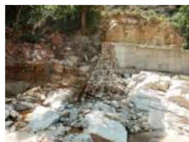
被災状況(既存の石積堰堤が崩壊した)
