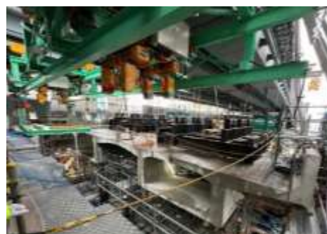
写真-1 撤去した PC 箱桁橋の断面
