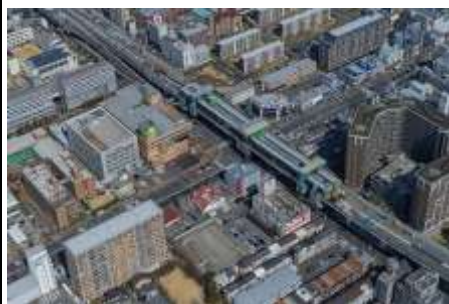
PC 箱桁橋撤去中の交差点
