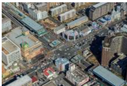
PC 箱桁橋撤去後の交差点
