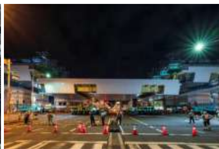
鋼製橋の架設
