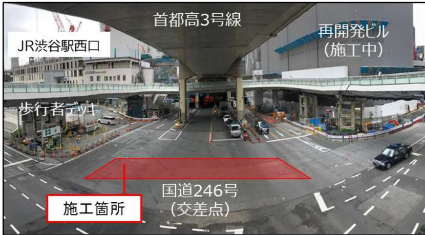
地下舗装整備箇所
