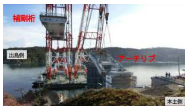
図－4 側径間ブロックの同時架設
