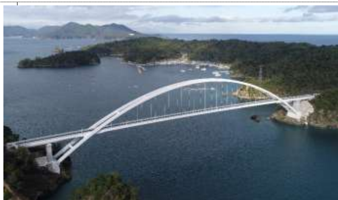
完成写真「出島大橋(いずしまおおはし)」 令和6年 12 月 19 日供用開始
