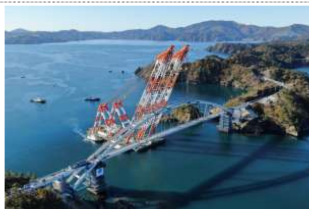
起重機船「海翔」による 鋼中路式アーチ橋の大ブロッケー括架設 令和5年 11 月 16 日
