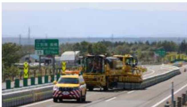
【写真1】 令和4年度 ロードジッパーシステム運用状況
