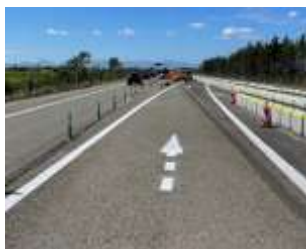
〔写真4〕 ⑤追越車線への誘導対策 (矢印路面標示（供用2日目）)
