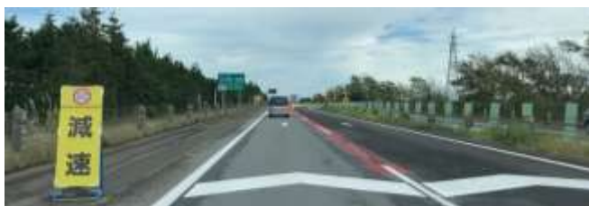
〔写真7〕⑫急な車線変更抑制対策として赤ライン実施状況 (供用3日目～)
