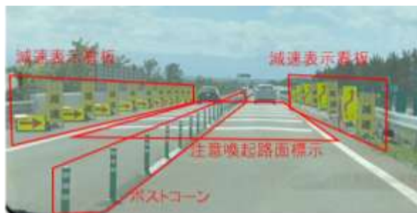
〔写真3〕 ③分岐手前の速度抑制対策実施状況
