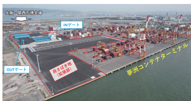
夢洲コンテナターミナル
