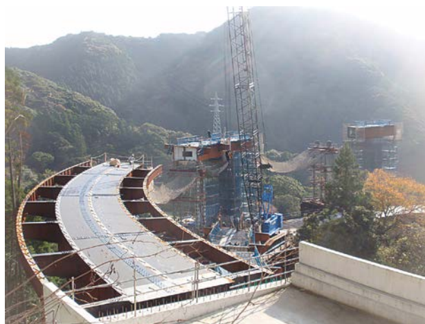
清澄山道ループ橋上部工施工中
