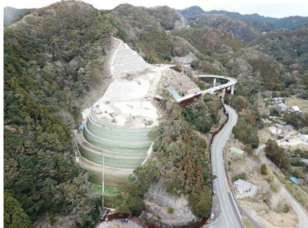
高さ約55mの補強土壁施工中
