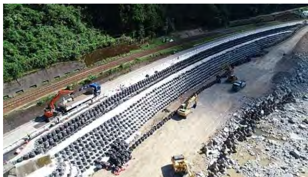
河川内の施工ヤード確保
